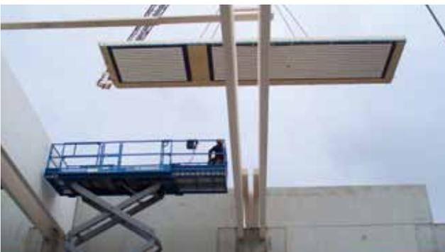
Montage der vorgefertigten Dachelemente
