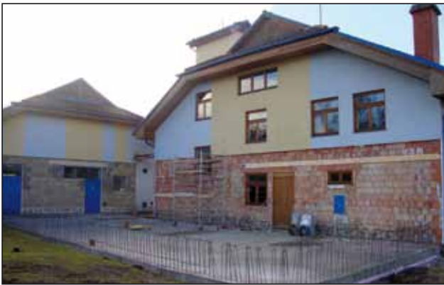
Errichtung der Bodenplatte
