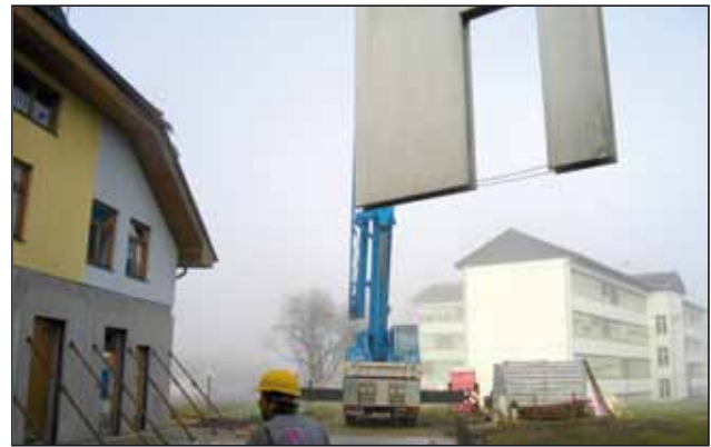
Aufstellen der Fertigbetonwände
