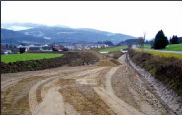
Beginn der Aufschließungsarbeiten
