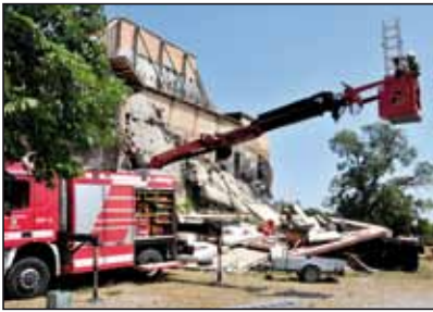
Hauseinsturz nach Erdbeben
