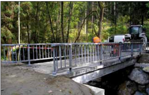
fertig gestellte Brennerbachbrücke
