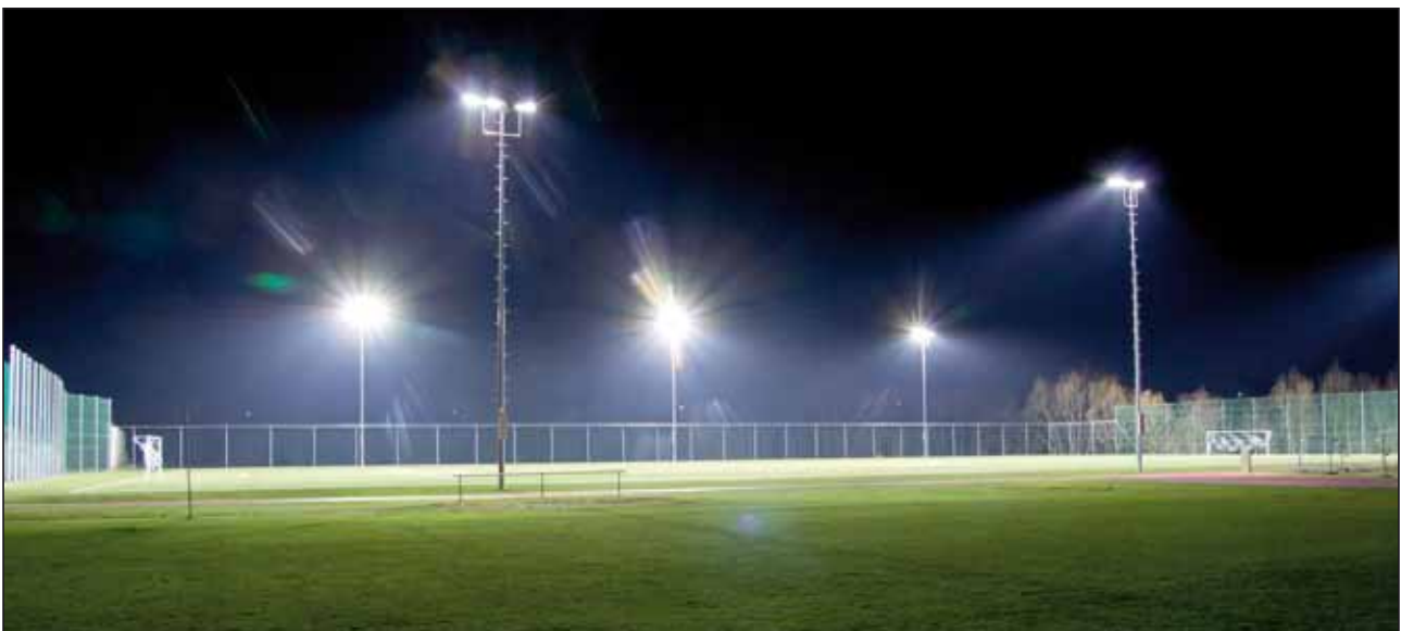
der neue Kunstrasenplatz mit meisterschaftstauglicher Flutlichtanlage
