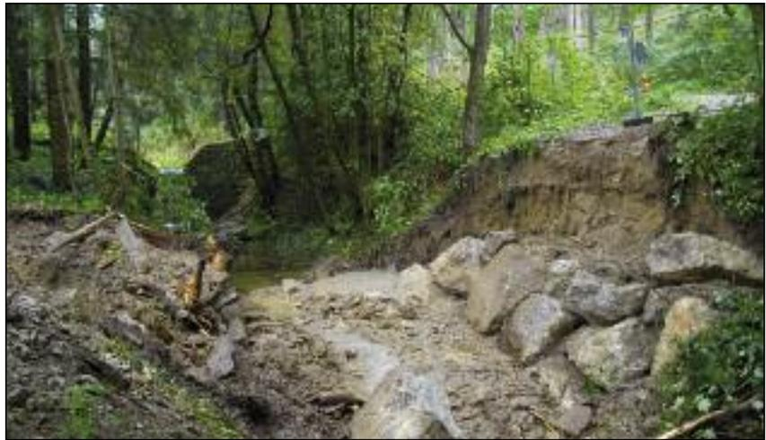
*Böschungssicherung mit einer neuen Steinschichtung*
