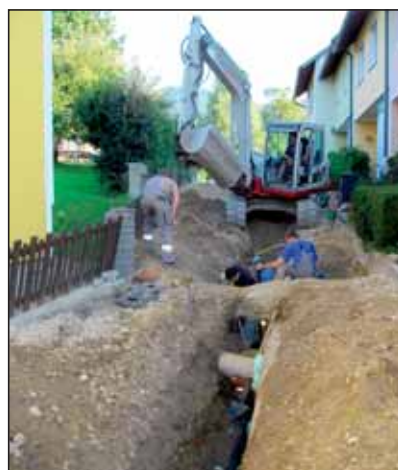
neue Wasserleitung Koglweg
