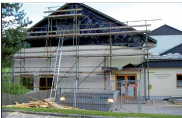
alte Außenansicht Kindergarten
