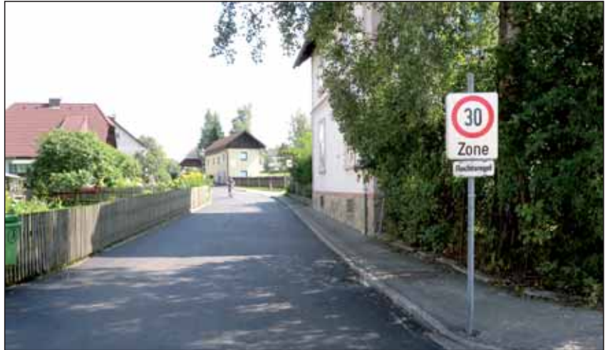
Steinfeldstraße - Zufahrt Hauptschule
