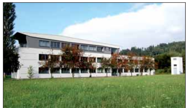
Zubau beim Bürogebäude
