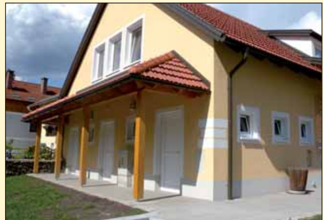
Zugangsbereich öffentliche WC-Anlage
