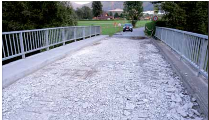
Rittisbrücke - Unterbeton schadhaft
