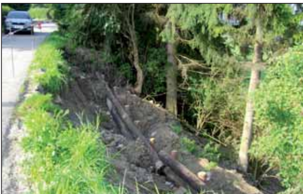
Hangrutschung Auffahrt Rainhof
