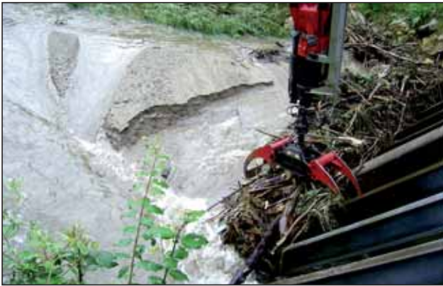
Räumung Geschiebesperre Freßnitzbach
