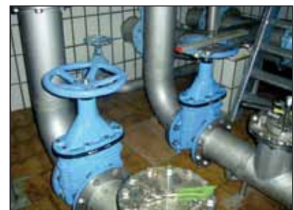
Rohrsystem Hochbehälter Feistritz
