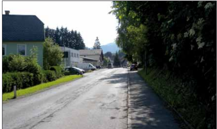
sanierungsbedürftige Grazer Straße
