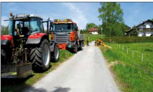
Bauarbeiten - Ausführung durch den Bauhof der Marktgemeinde Krieglach
