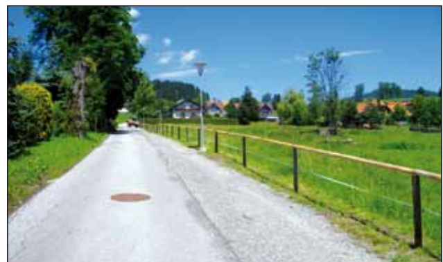
Fertigstellung der Straßenverbreiterung und des Zaunes
