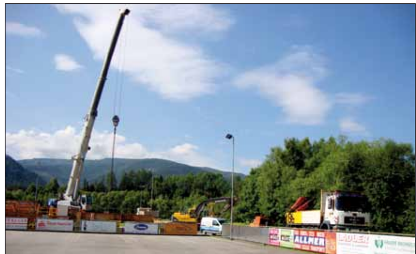
Beginn der Bauarbeiten
