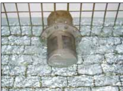
Becken mit Filteranlage im Hochbehälter Feistritz
