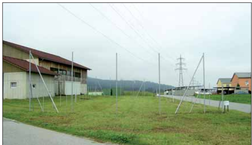
Errichtung der Zaunanlage
