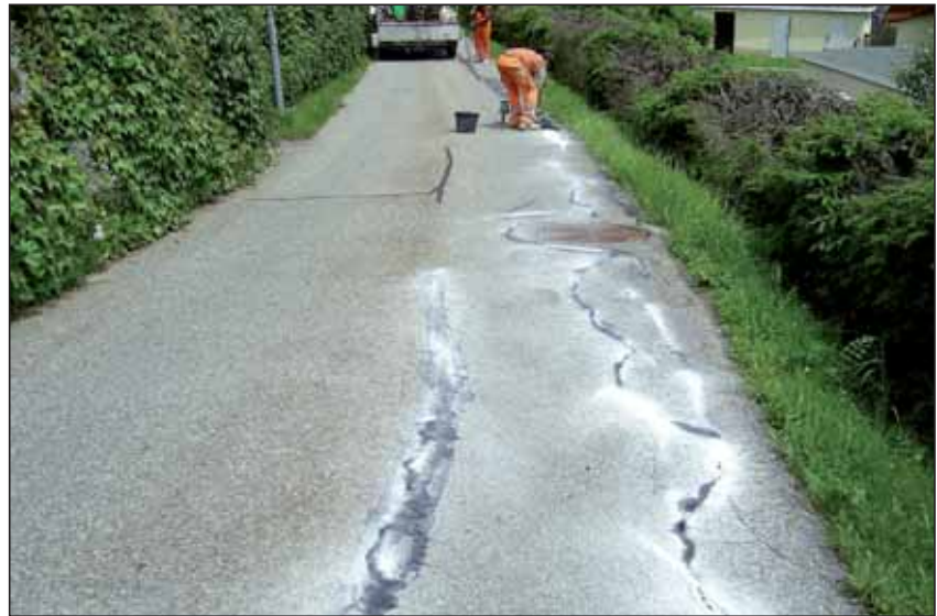
Heißverfugung der Asphalttrisse
