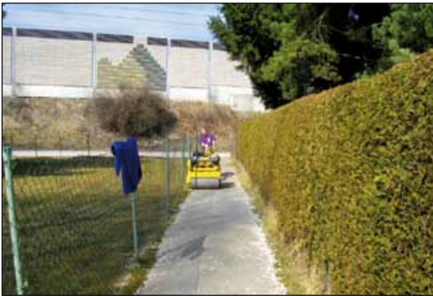
Sanierungsarbeiten durch den Gemeindebauhof
