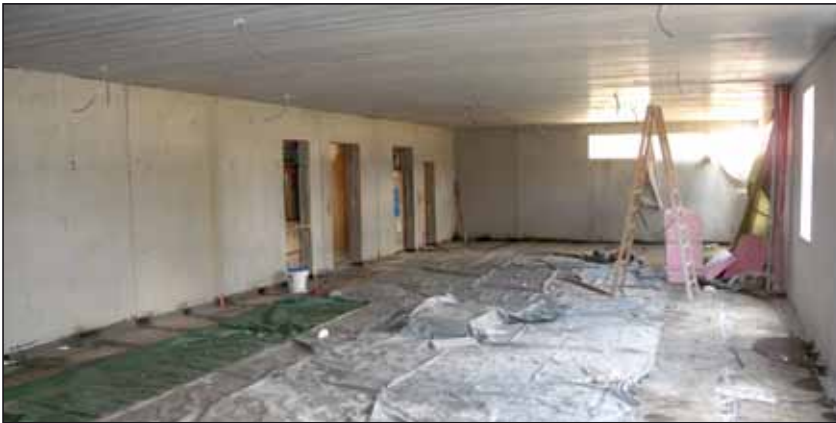
Rohbau - Zubau FF Krieglach/Rotes Kreuz
