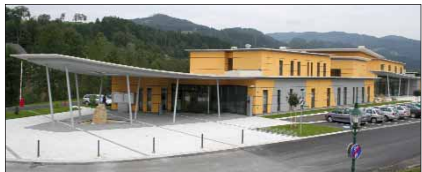
fertig gestelltes Gemeinde- und Veranstaltungszentrum
