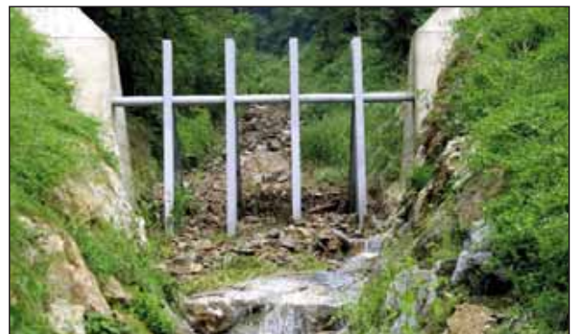
Geschiebesperre „Drei Brunnen“
