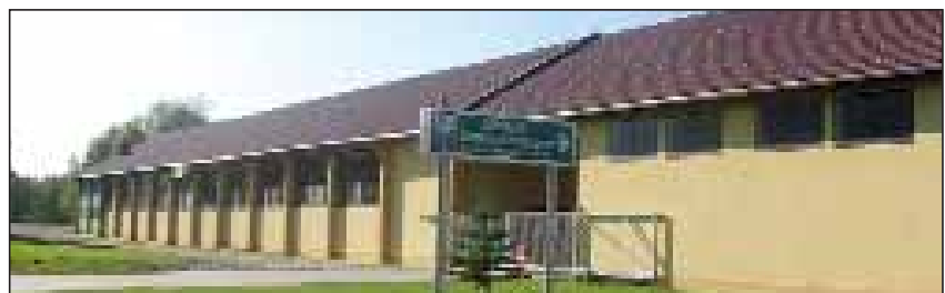
Bauhof - Zufahrt Altstoffsammelzentrum
