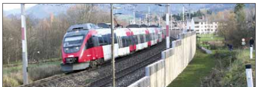
Errichtung von Lärmschutzwänden
