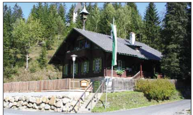
Waldschule - neue Stützmauer und Zaun
