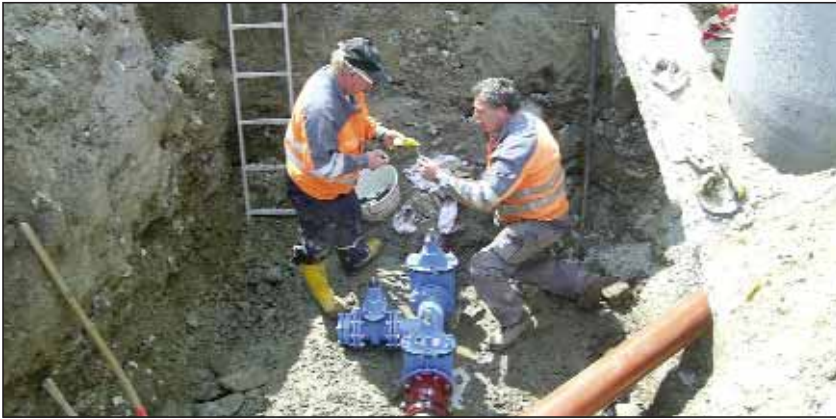
Wasserleitungsbau Freßnitz - Ringleitung
