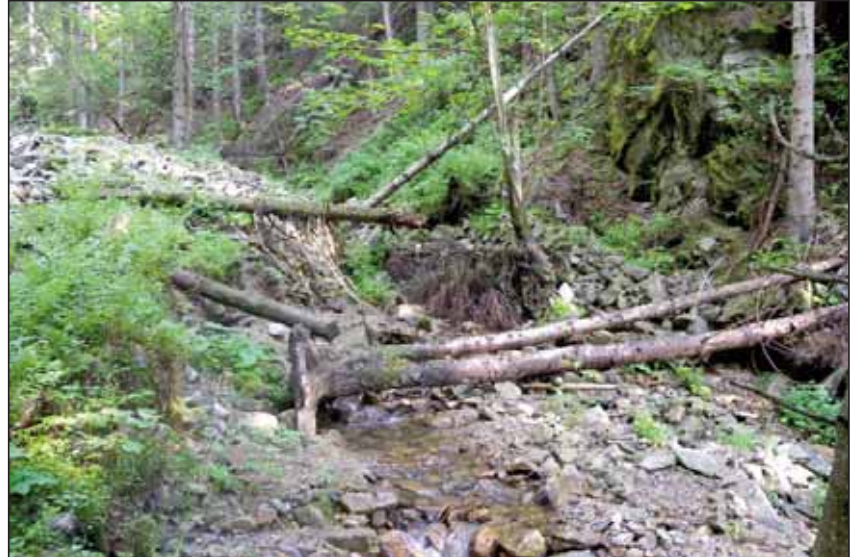
Beispiel eines Abflusshindernisses
