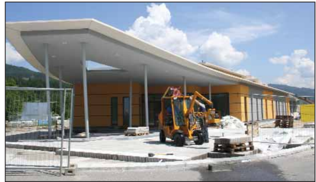
Verlegung der Pflastersteine
