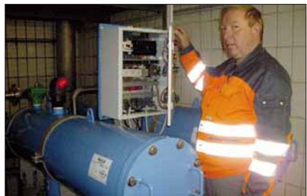
Filteranlage - Hochbehälter Feistritzgraben
