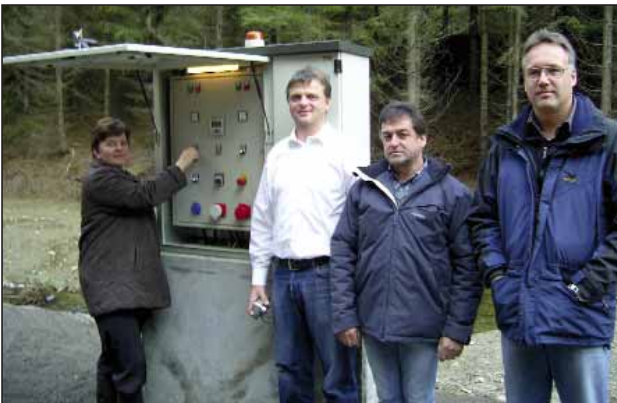
Pumpstation - Kanal Alpl -Inbetriebnahme
