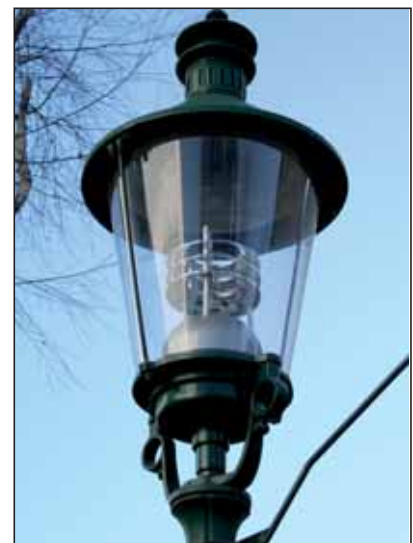
Straßenlaterne mit neuem Leuchtmittel
