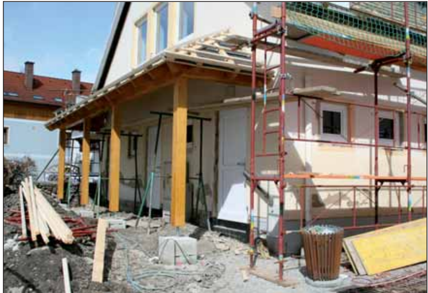
Sanierung des Pfarrsaals und des öffentlichen WC's
