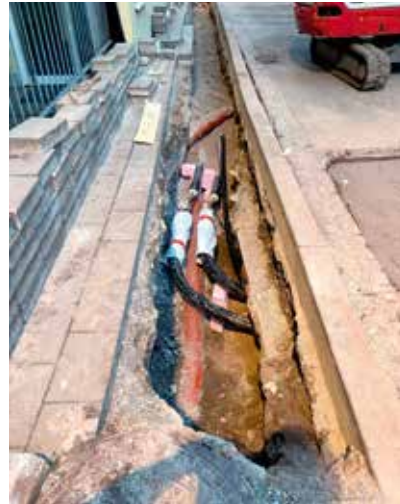
Neuaufschließung der Nahwärme im Zentrum sowie Erneuerung der Wasser- und Erdgasleitung
