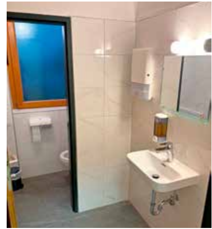
Generalsanierung der Lehrer-WCs
