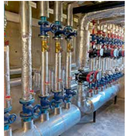
Erneuerung des Heizungsverteilers, der Pumpen und der elektronischen Steuerung
