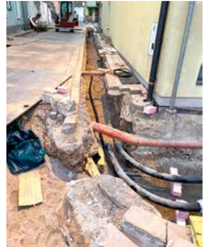
Neuaufschließung der Nahwärme im Zentrum sowie Erneuerung der Wasser- und Erdgasleitung
