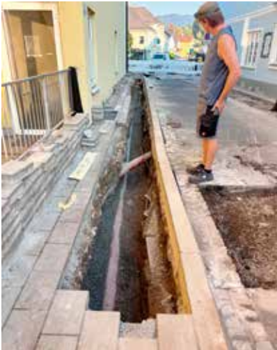
Neuaufschließung der Nahwärme im Zentrum sowie Erneuerung der Wasser- und Erdgasleitung
