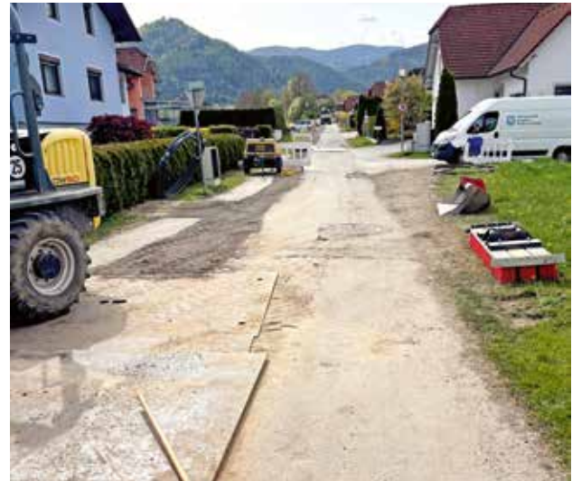
umfangreiche Grabungsarbeiten zur abschnittswisen Generalsanierung der Wasserleitung im Wiesenweg
