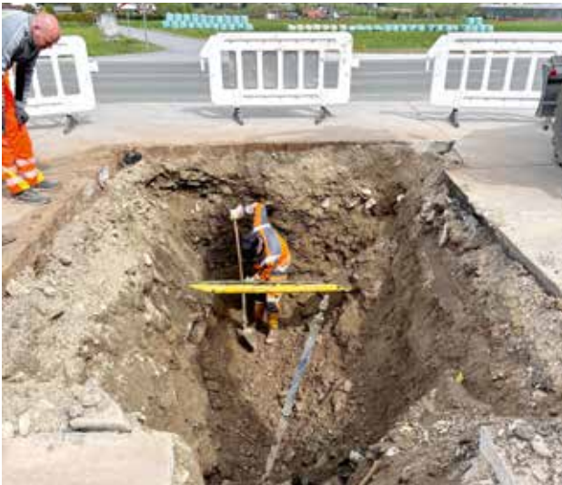
umfangreiche Grabungsarbeiten zur abschnittswisen Generalsanierung der Wasserleitung im Wiesenweg
