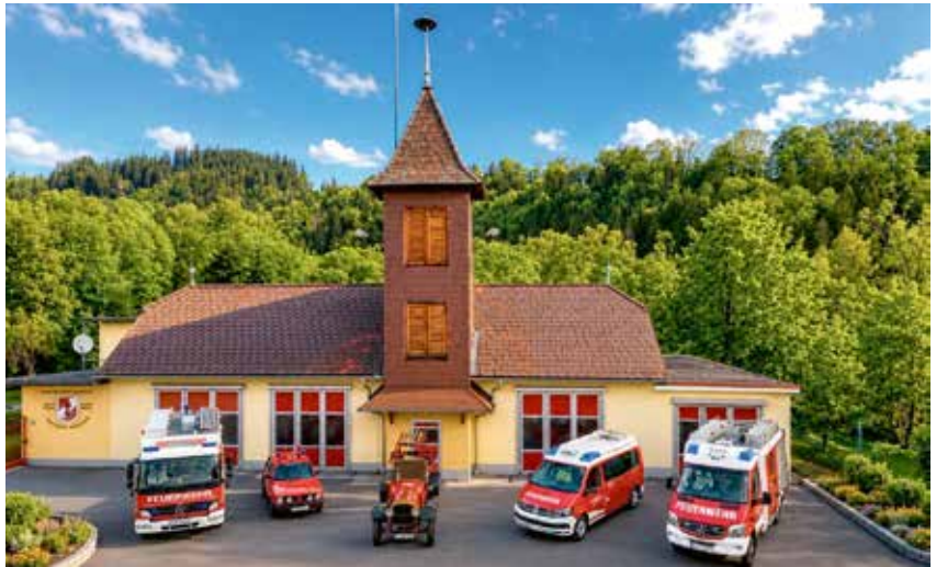
Rüsthaus und Fuhrpark der Freiwilligen Betriebsfeuerwehr voestalpine Rotec GmbH
