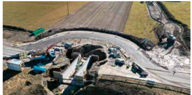
Hochwasserschutz Traibach Errichtung des Brückenbauwerks
