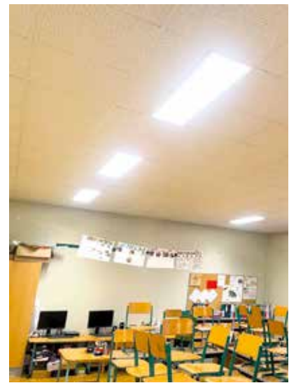
passgenau wurden die neuen LED-Leuchten eingesetzt
