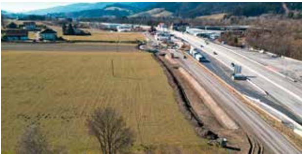
Hochwasserschutz Traibach Vorbereitungsarbeiten
