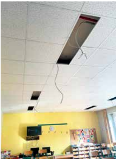
Entfernung der alten Leuchten
