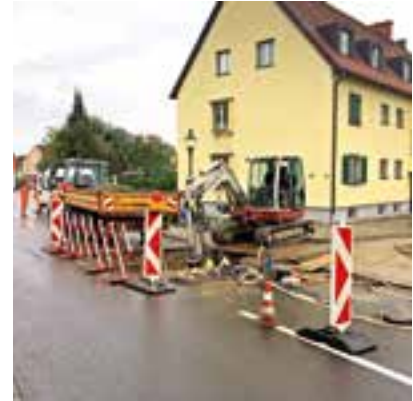
...und Erneuerung der Wasserleitungen
