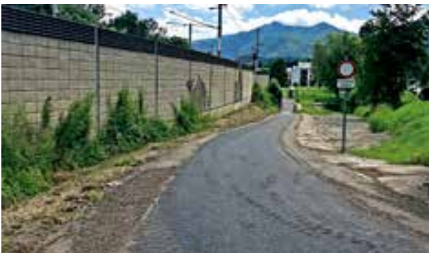
Sanierung und Verbreiterung des Geh- und Radweges Kernstockweg
