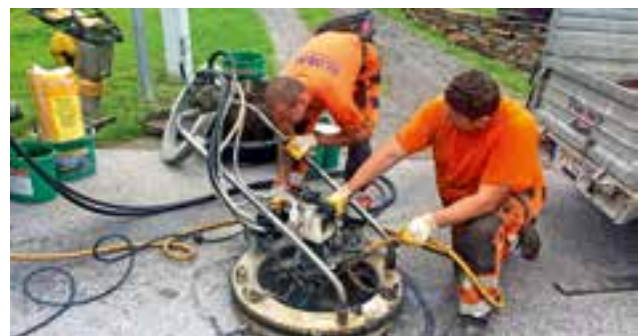
Sanierung von Fäkalkanalschächten
