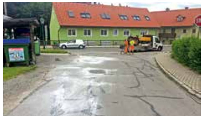
Verfugung von Asphalttrissen
