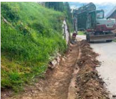
Sanierung der Oberflächenentwässerung im Bereich Bruggraber
