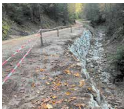
Ufersicherung mittels neuer Steinschlichtung
