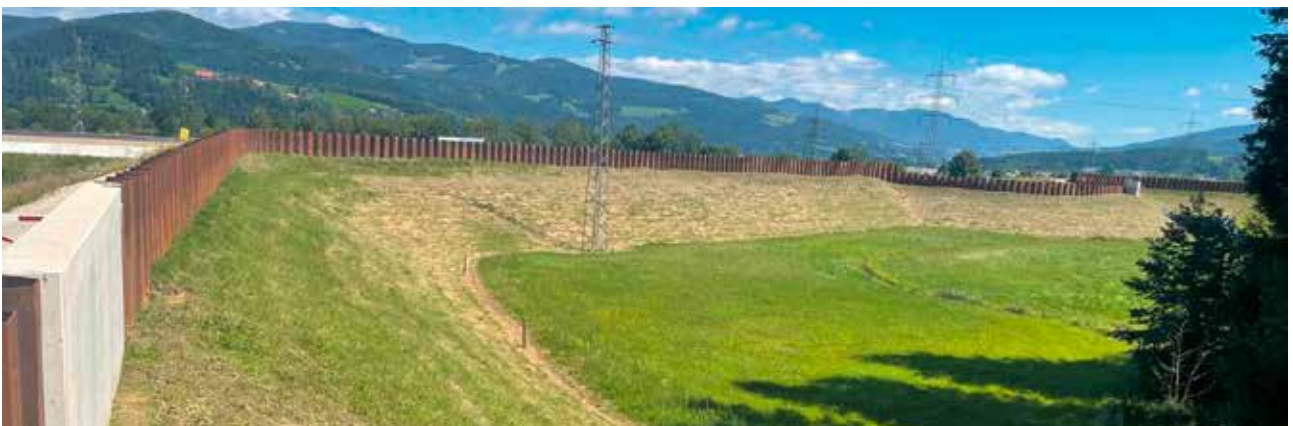
Rückhaltebecken mit aufgesetzten Spundwänden
