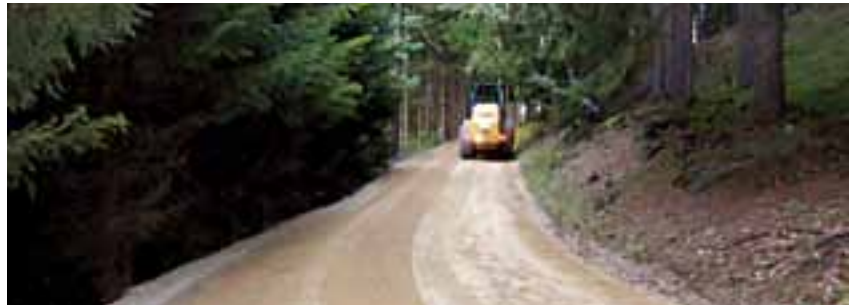
Sanierung von landwirtschaftlichen Hofzufahrten
