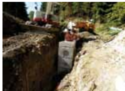
Versetzen eines Drainageschachtes
