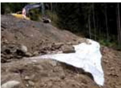
Verlegung einer starken Gewebeplane
