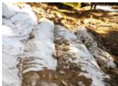
schichtweise erfolgt die Hangstabilisierung
