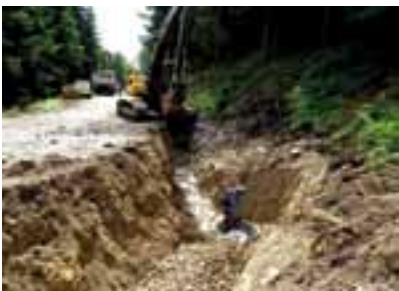
Verlegung einer neuen Drainage
