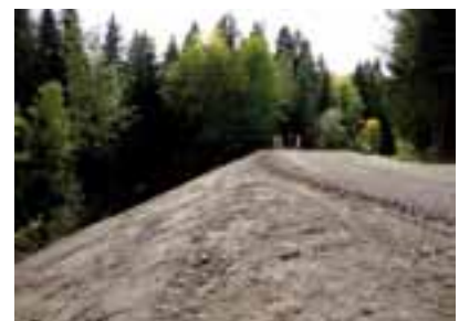
fertig aufgebaute Böschung
