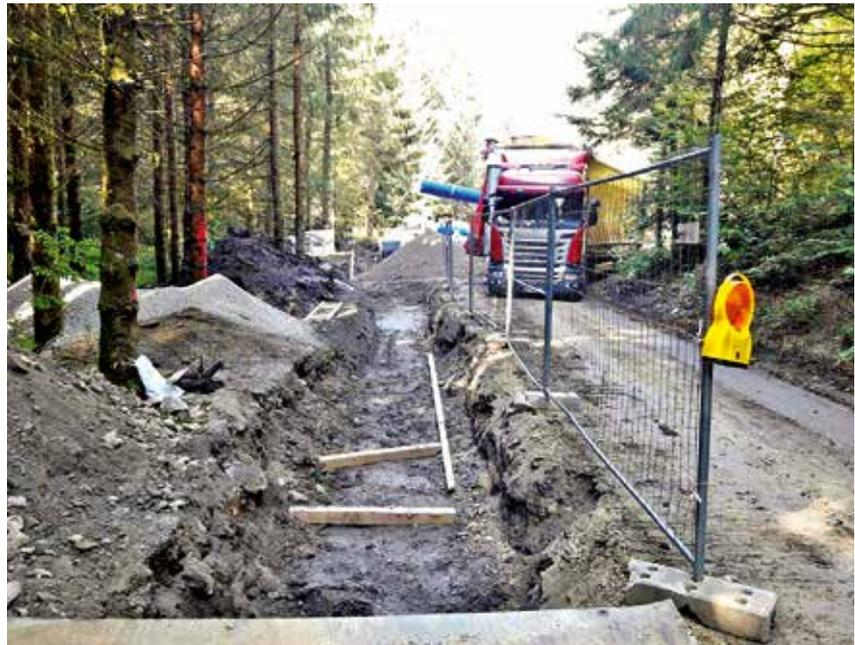
Auf einer **Strecke von rund 3.500 Metern** wird entlang des Freßnitzbachs eine Rohrleitung mit einem Durchmesser von 800 mm bzw. 600 mm verlegt. Aufgrund des Höhenunterschiedes entsteht ein entsprechender Druck, sodass beim Kraftwerksbau eine Turbine angetrieben werden kann, die eine Strommenge von rund **2.700.000 kWh/Jahr** erzeugen wird.
