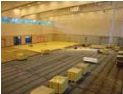
Verlegung des Hallenbodens
