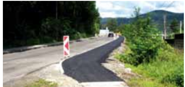
Grazer Straße - mit neu errichtetem Gehsteig
