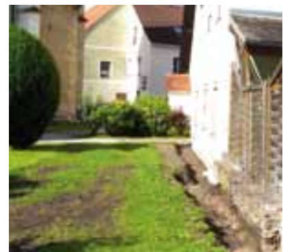
Trockenlegung der Außenmauern
