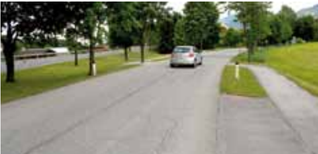
Einfahrt Freßnitz-West - vor Errichtung des Gehsteiges
