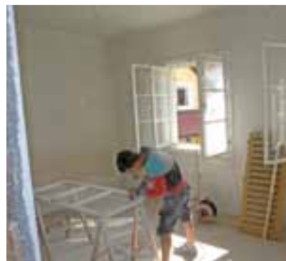
Sanierung der Fenster
