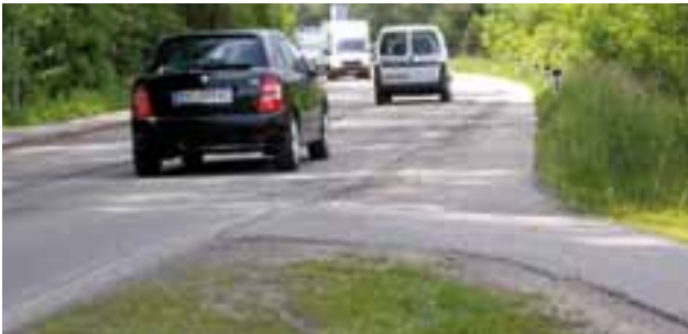
Grazer Straße - vor Errichtung des Gehsteiges
