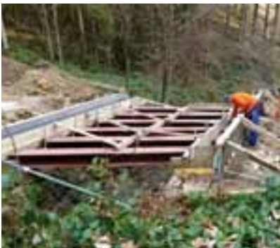
Sanierung der Brückenköpfe und Einsetzen der tragenden Elemente
