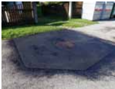
Kanalschachtsanierung
