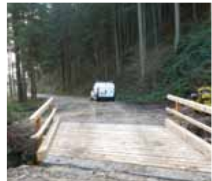
fertig gebaute Brücke
