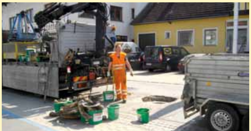
Kanaldeckelsanierung - Grazer Straße
