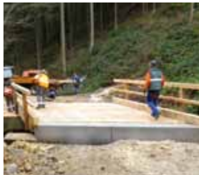
Montage des Brückenbelages und des Geländers
