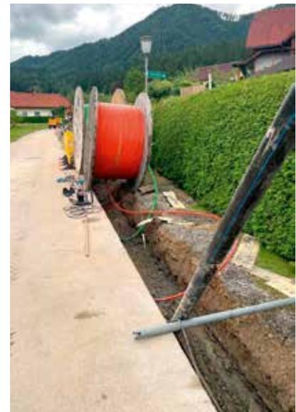
*Glasfaserleitungen wurden im Auftrag der Alpenglasfaser mitverlegt*
