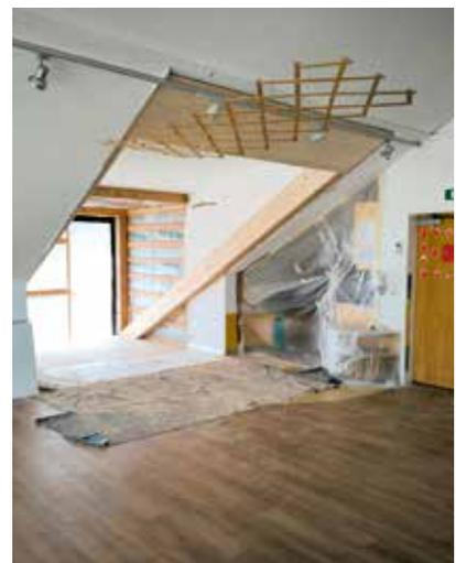
*Ausbau im Obergeschoss zur Schaffung eines Fluchtweges*
