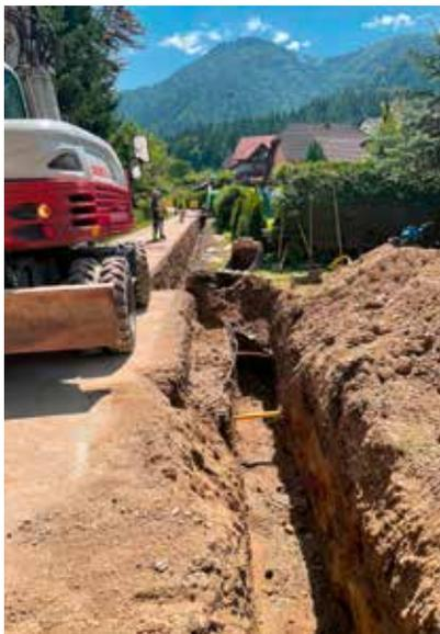
*Verlegung der neuen Wasserleitungsrohre in offener Bauweise*
