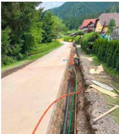
Mitverlegung von Glasfaserkabeln im Wassertrale im Zuge des Wasserleitungsprojektes
