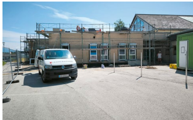
Errichtung des Zubaus in Fertigbauweise
