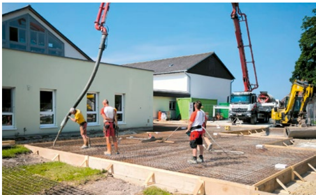
die Bodenplatte wird betoniert
