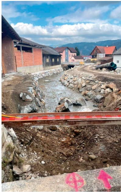
Arbeiten Nähe Landesstraße
