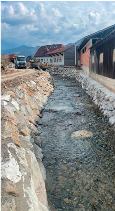
aufwändige Bachausbau- und Fundamentarbeiten
