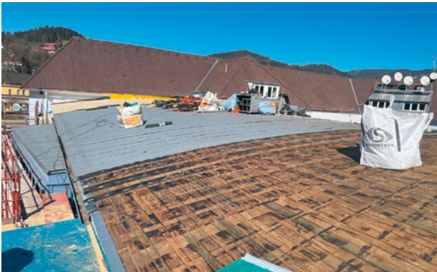
das alte Blechdach wurde entfernt
