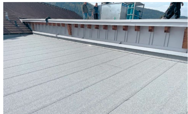
alle Abschlüsse wurden mit Blech eingefasst
