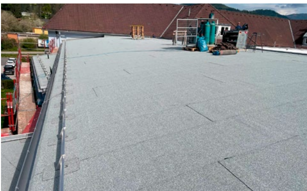
Mitte Mai wurden die Zimmerer, Dachdecker- und Spenglerarbeiten fertiggestellt
