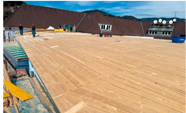
vollflächig wurde ein Kaltdach aufgebracht
