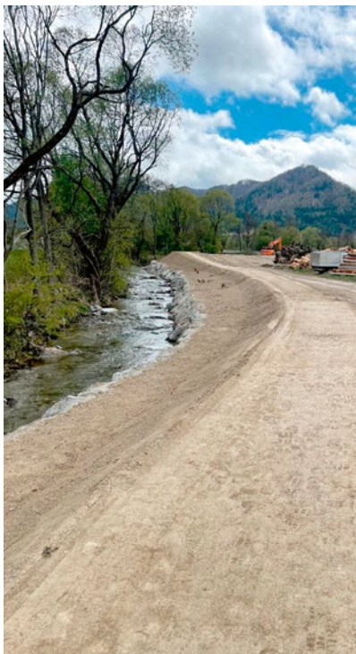
Errichtung von Dämmen entlang des Freßnitzbaches
