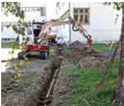
Verlegung und Installation eines Glaserfaserkabels für leistungsfähiges WLAN
