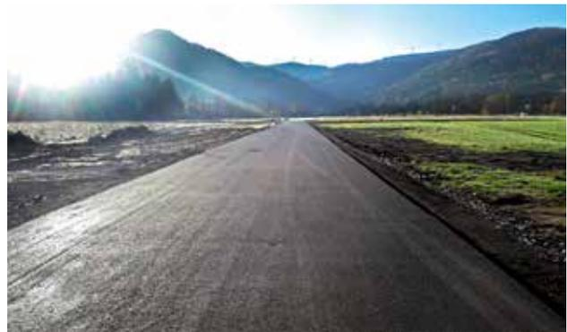
Die Arbeiten zur Aufschließung von **27 Baugrundstücken in der Gartengasse** (Freßnitz – vis a vis Lidl-Markt) konnten **abgeschlossen** werden. Sämtliche Ver- und Entsorgungsleitungen wurden ordnungsgemäß verlegt und die Zufahrtsstraße durch Aufbringen einer Asphaltsschicht staubfrei gemacht. In der Folge wurden sämtliche Grundstücksgrenzen von einem beideten
