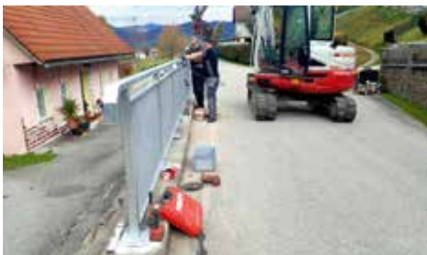
Montage des neuen Geländers entlang des Postmühlwegs
