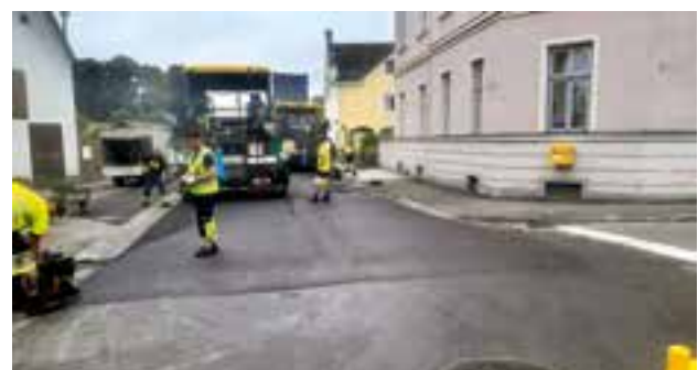
Aufbringen der neuen Asphaltenschicht mit zwei Fertigern – ohne Mittelnaht
