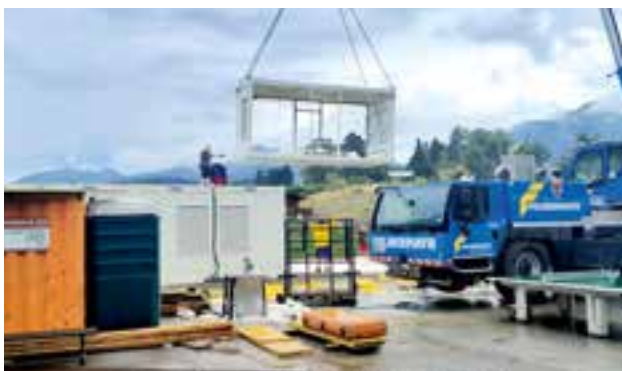
Anlieferung und Einheben der Fertigmodule
