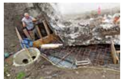
Fundamentsanierung
