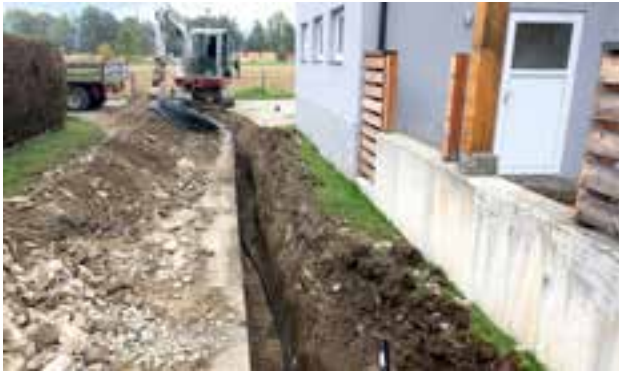
ständige Sanierung und Erneuerung des Wasserleitungsnetzes
