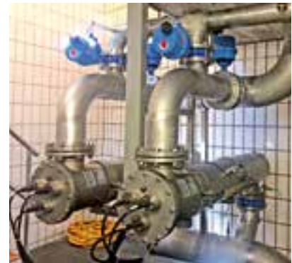
Einbau einer UV-Entkeimungsanlage
