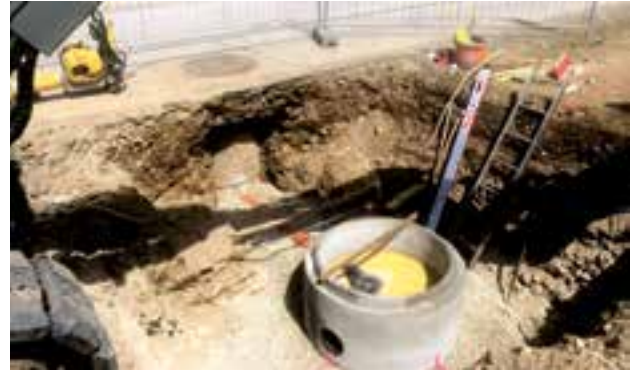
Aufschließung - Kanal-Wasserleitung - Lindenstraße
