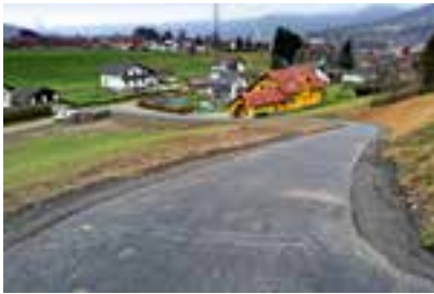
Gehweg Höllweg - Alplstraße – Neuanlage
