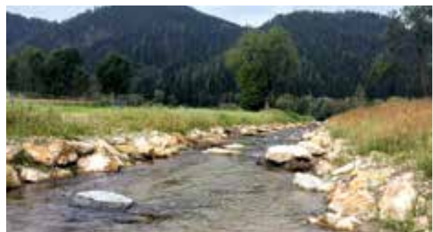
Hochwasserschutz Freßnitzbach - Unterlauf
