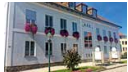
Volksschule neue Fenster
