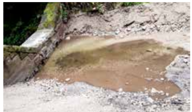
Pflege und Räumung des Rückhaltebeckens Steingrabenbach
