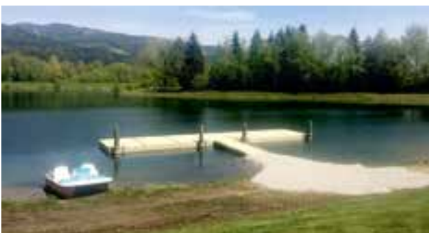
Errichtung eines neuen Bootsstegs am Freizeitsee
