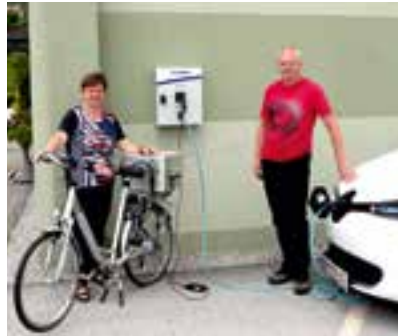
Errichtung und Betrieb einer E-Tankstelle
