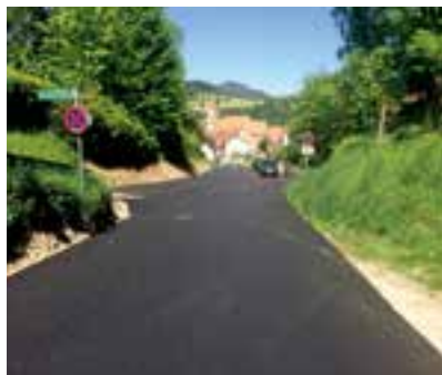
Karl-Morre-Gasse - Generalsanierung in zwei Bauabschnitten
