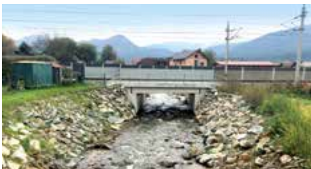
Hochwasserschutz Freßnitzbach - Neuerrichtung der ÖBB-Brücke
