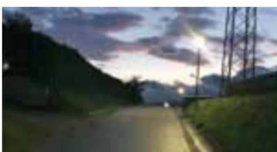
Erweiterung - Straßenbeleuchtung Wassertalweg-Friedhofweg
