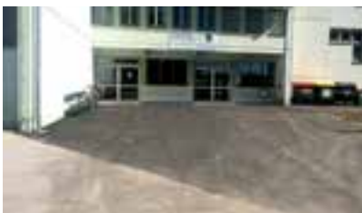
NMS - Vorplatz Asphaltierung
