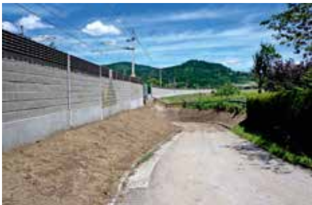
Errichtung von Lärmschutzwänden - ÖBB-Trasse Freßnitz
