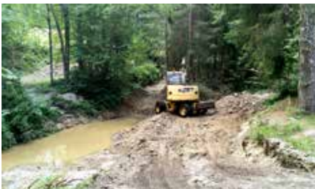
massive Anlandungen im Rückhaltebecken Brennerbach
