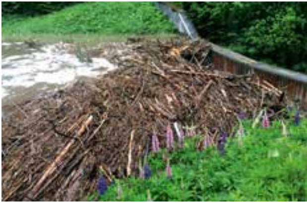
Hochwasser Freßnitzbach - Grobgeschiebesperre
