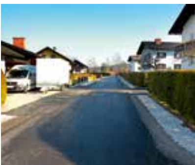
Am Koglacker - Generalsanierung
