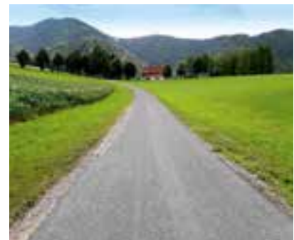
Himmelweg - Aufbringen einer Spritzdecke
