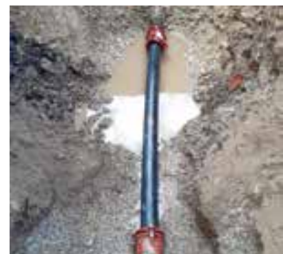
Behebung von Rohrbrüchen
