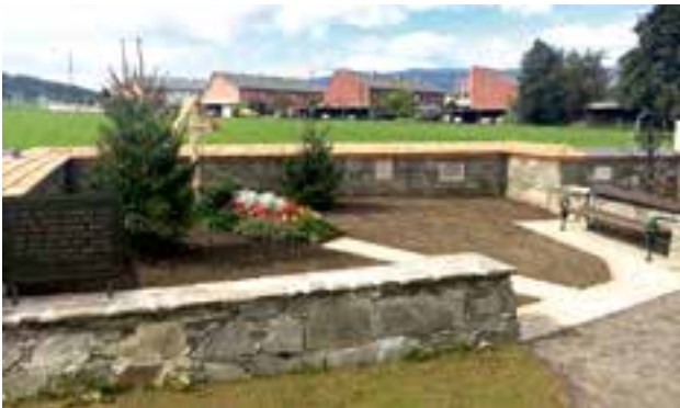
Generalsanierung der Grabstätte Peter Roseggers
