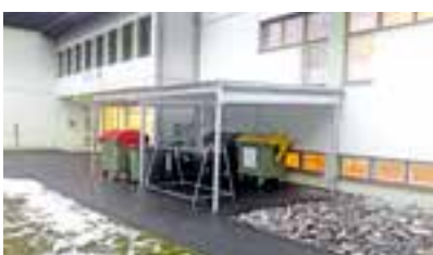
NMS - Überdachung Müllstation
