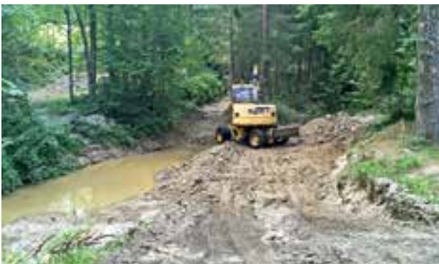
Räumung Rückhaltebecken Brennerbach
