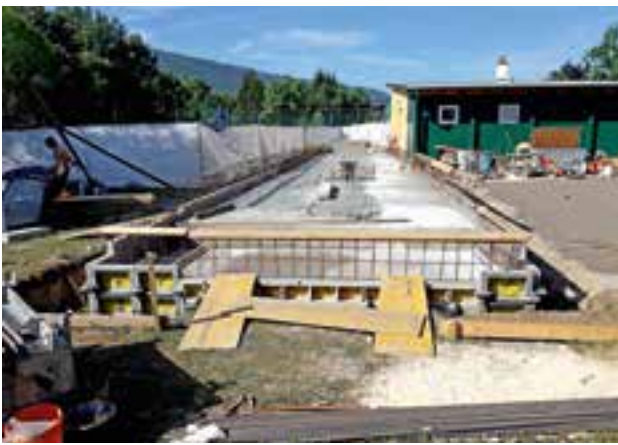
Errichtung der Bodenplatte samt den erforderlichen Anschlüssen
