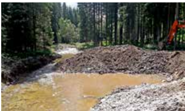
massive Anlandungen Freßnitzbach Bereich Alpl
