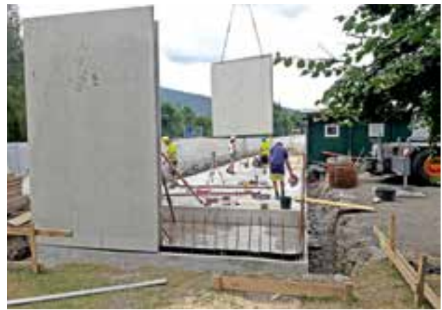
Aufstellen der Betonfertigwände
