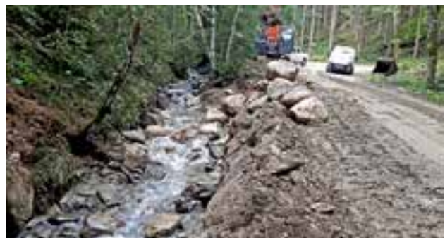
Ufersanierung Zubringerbach – Freßnitzbach
