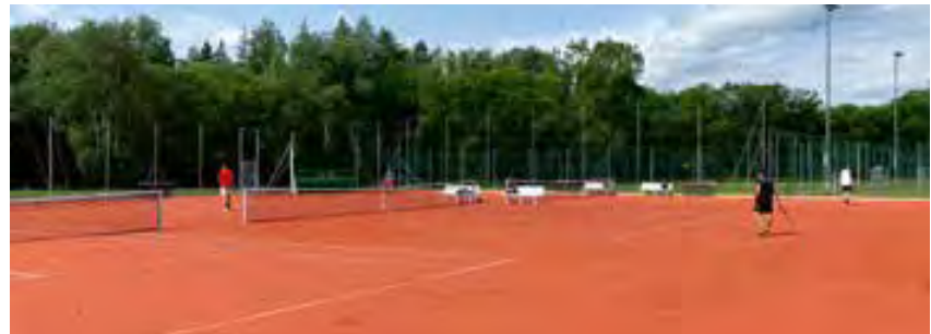
der rote Kunstrasenbelag wurde aufgebracht, mit Sand verfüllt und die Linien verlegt und bereits in Betrieb genommen
