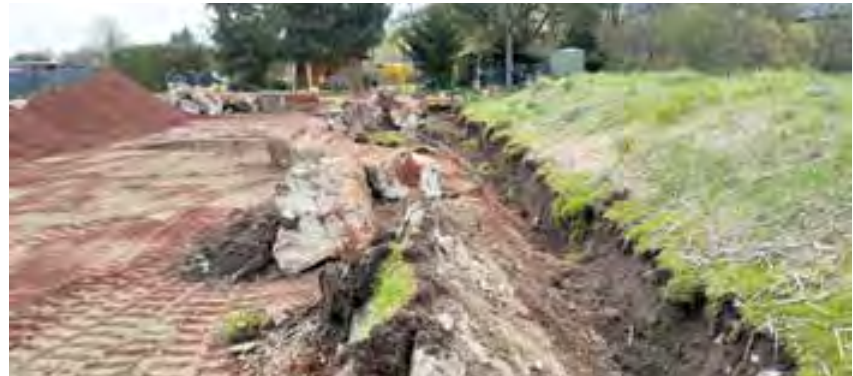
Abtragen des alten Tennissandes, der Fundamente und Vorbereitung der Fläche
