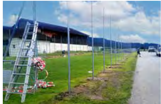
die Zaunsäulen für den Ballfangzaun wurden bereits versetzt
