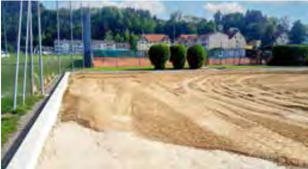
Aufbringung der Sauberkeitsschicht
