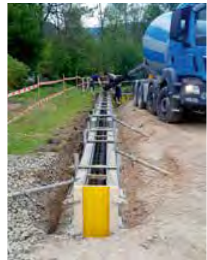
Betoneinfassung für die neue Einzäunung
