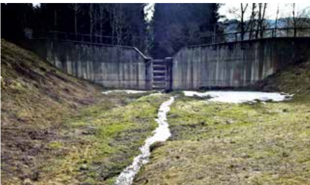
die morsche Balkensperre aus Holz wird durch eine Eisenkonstruktion ersetzt
