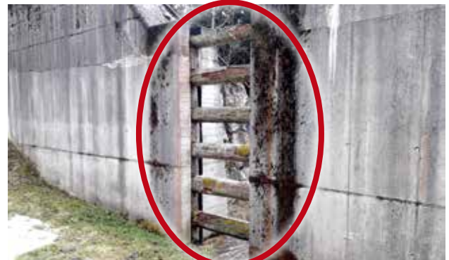
die morsche Balkensperre aus Holz wird durch eine Eisenkonstruktion ersetzt
