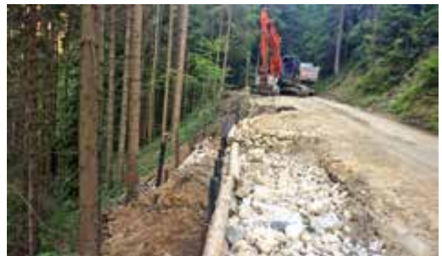
Verfüllung mit Spezialschotter
