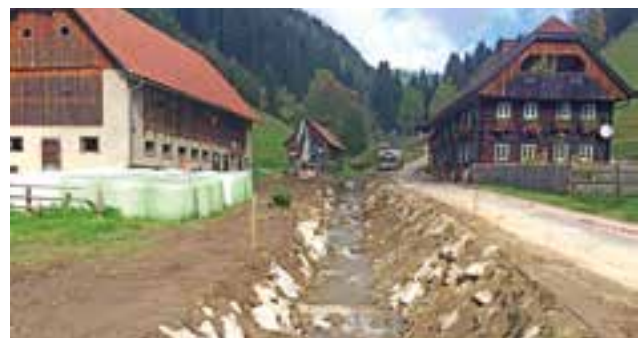
Ufersanierung durch die Wildbach- und Lawinenverbauung
