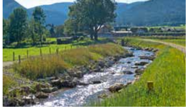
naturnaher Ausbau des Freßnitzbach-Unterlaufs
