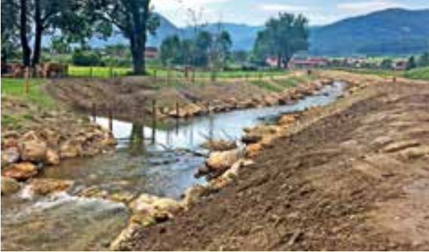
Freßnitzbach unmittelbar nach Abschluss der Bauarbeiten
