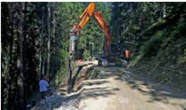
Versetzen von Stahlrohren
