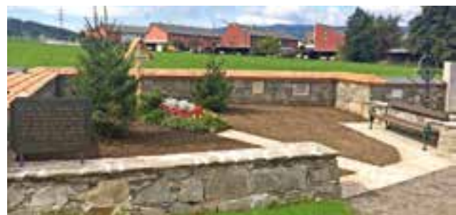
Roseggergrabstätte nach der Sanierung
