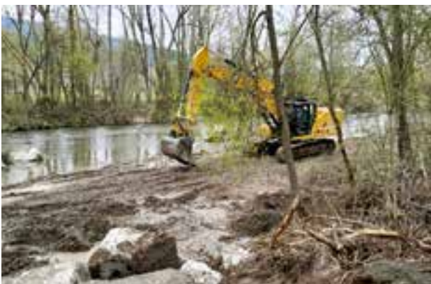
Baggerarbeiten zur Verbesserung der Fließverhältnisse und des Hochwasserschutzes entlang der Mürz
