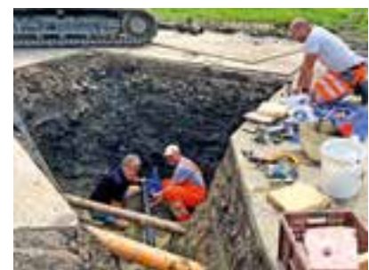
Erneuerung der Wasserleitung in der Steinfeldsiedlung
