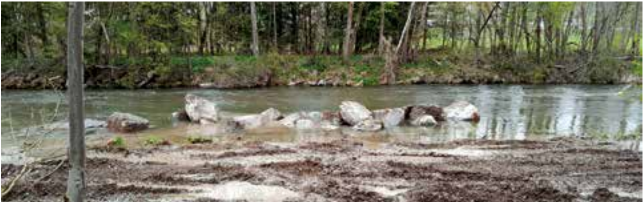
Entfernung der Anlandungen durch die Baubezirksleitung Obersteiermark Ost
