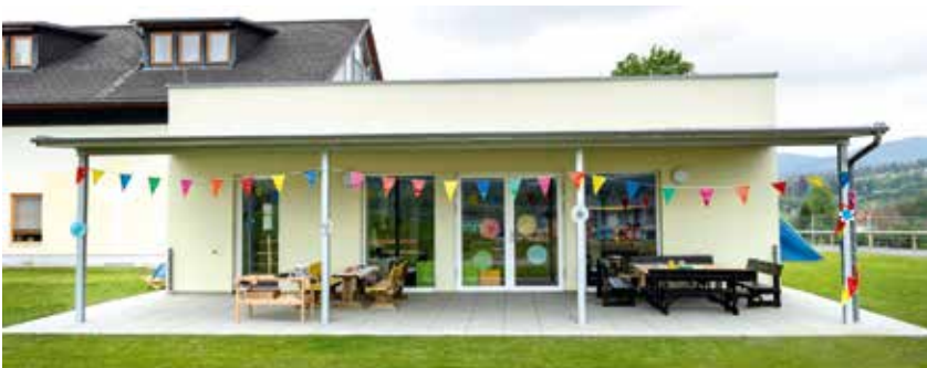
Kinderkrippe – Terrasse und Freibereich
