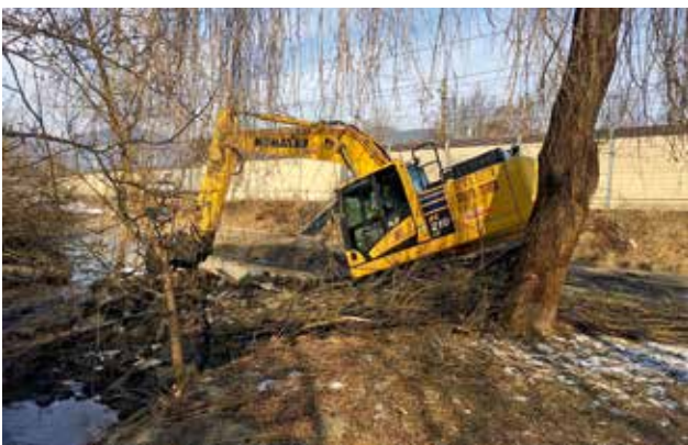
Baggerarbeiten im unwegsamen Gelände
