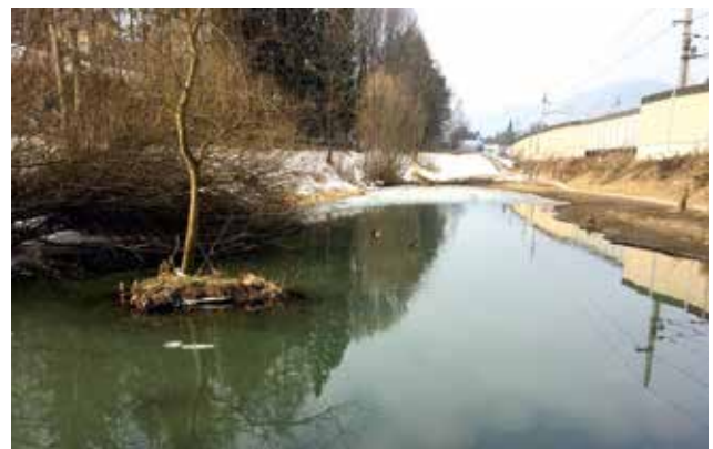
Abschluss der Bagger- und Sanierungsarbeiten
