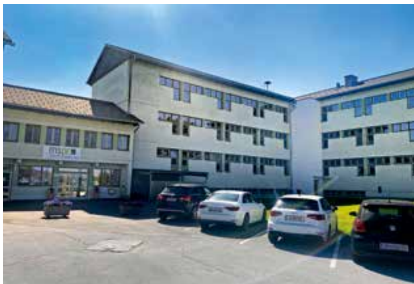
in der Mittelschule werden die Sanitärtrakte erneuert und barrierefrei gestaltet
