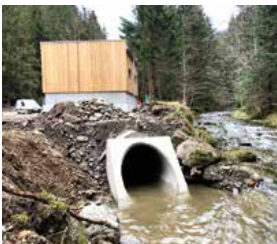
Kraftwerkshaus – Ausleitung in den Freßnitzbach
