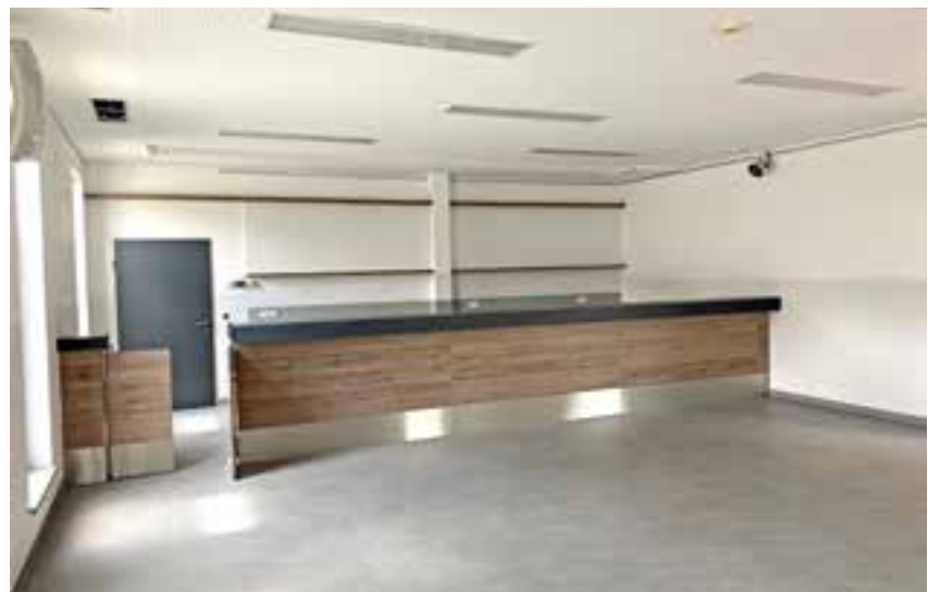
Sanierung und Erneuerung des Barbereichs in der Disco
