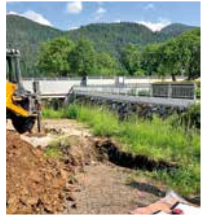
Bodenerkundungen entlang des Freßnitzbachs
