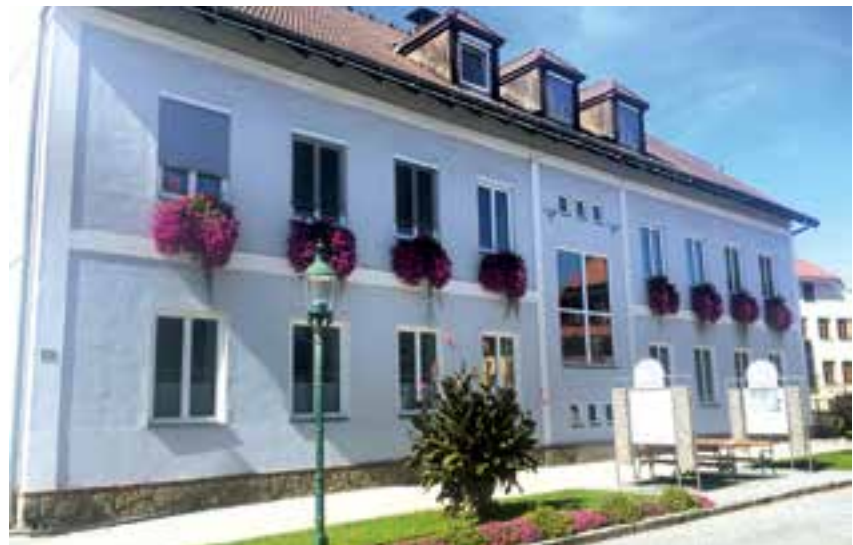
die Fassade der Volksschule Krieglach wird saniert
