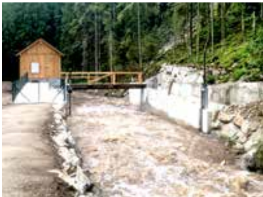
Einleitung in die Druckrohrleitung
