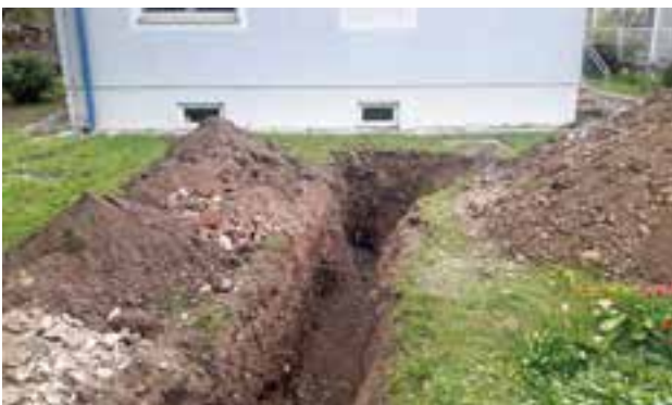
über 30 Hausanschlüsse wurden erneuert
