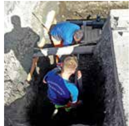
Erneuerung der Wasserleitung
