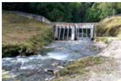
Grobgeschiebesperre Freßnitzbach
