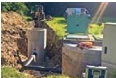
Verlegung der Transportleitung und Setzen der Technikschächte
