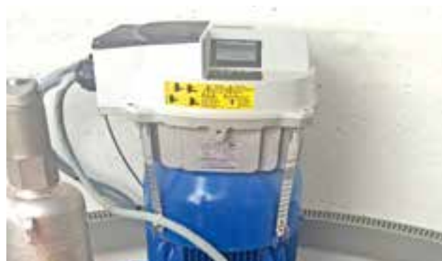
Absperr- und Zuflusssystem mit moderner frequenzgesteuerter Pumpe
