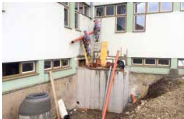
umfangreiche Erdbewegungsarbeiten und Optimierung der Oberflächenentwässerung
