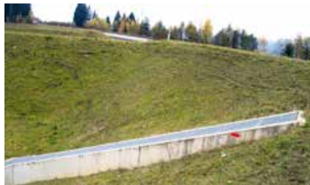
Dammkron mit Höhenmarken
