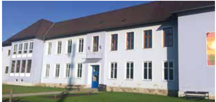
bahnseitiger Gebäudetrakt kurz vor Abschluss der Arbeiten
