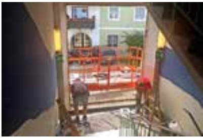
Einbau von großflächigen Fenstern
