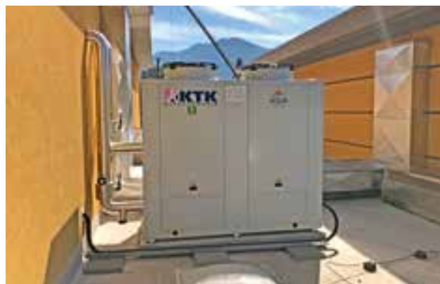
Installation des Klimagerätes
