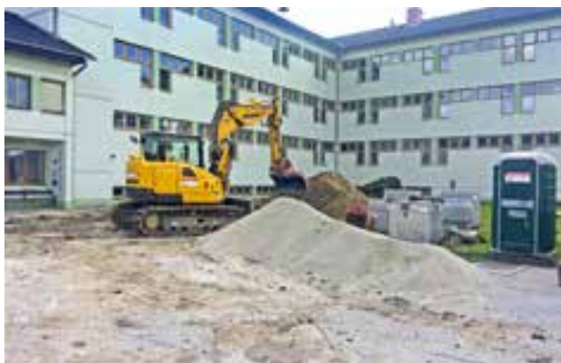
umfangreiche Erdbewegungsarbeiten und Optimierung der Oberflächenentwässerung
