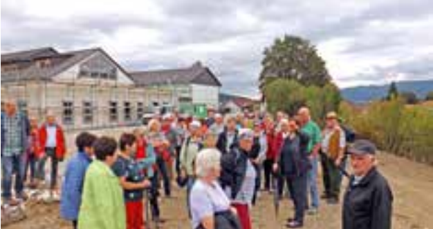
Errichtung der Kinderkrippe
