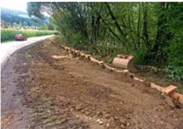
die Schlachtenwand wurde mit Erdmaterial dammförmig eingeschüttet und begrünt
