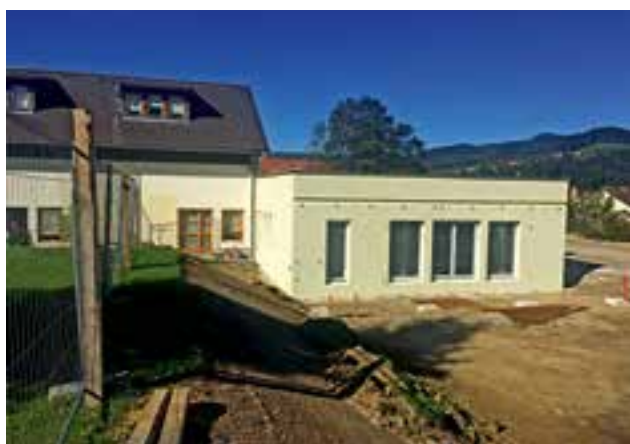
Fertigstellung des Rohbaus und farbliche Abstimmung mit dem Hauptgebäude
