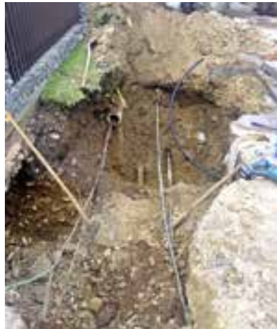
Verlegung der Wasserleitungsrohre unter schwierigen Bedingungen
