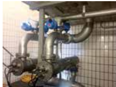
UV-Entkeimungsanlage mit modernem Fernmeldesystem
