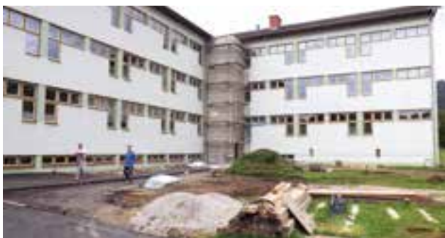
Bauarbeiten Aufzug und Vorplatz - NMS
