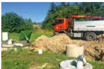
Verlegung der Transportleitung und Setzen der Technikschächte
