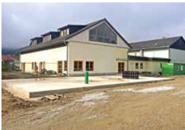
Errichtung der Bodenplatte und des Rohbaus
