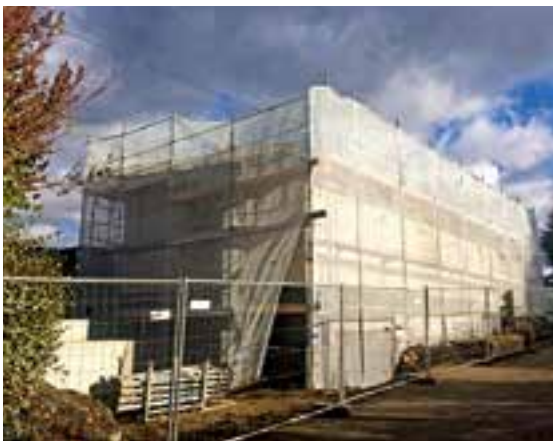
Errichtung eines neuen Stellwerks
