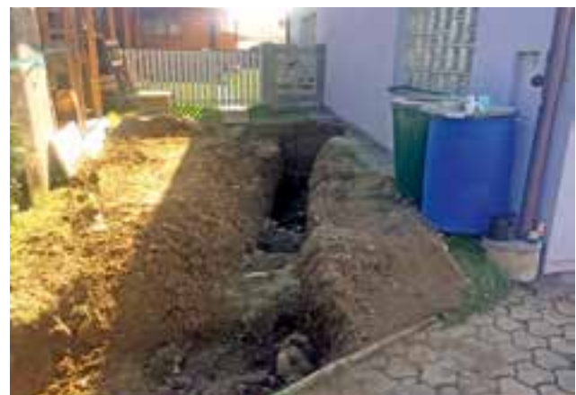
Erneuerung von Hausanschlüssen
