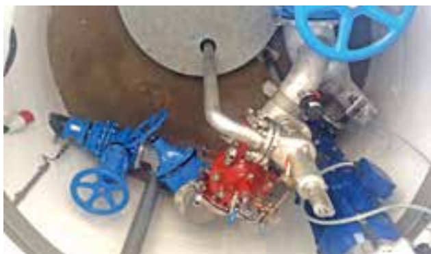
Absperr- und Zuflusssystem mit moderner frequenzgesteuerter Pumpe
