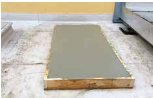
Herstellen einer Fundamentplatte am Dach des VAZ
