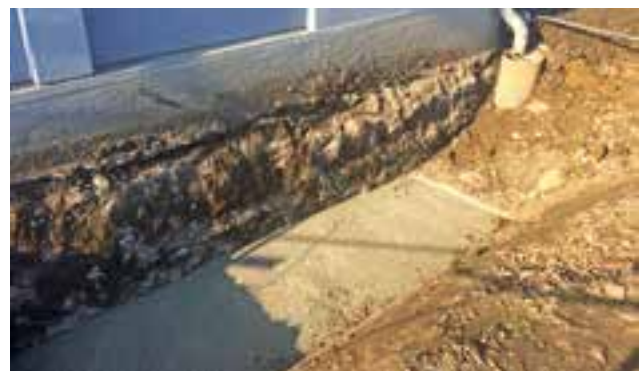
Fixierung der Eisenkonstruktion mit Beton
