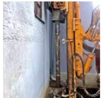
Tiefenbohrung - Einsetzen der Eisenstäbe
