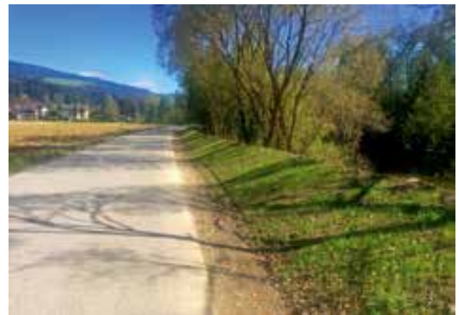
die Schlachtenwand wurde mit Erdmaterial dammförmig eingeschüttet und begrünt
