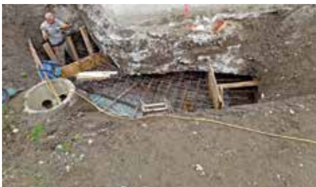
Verbindung der Eisenstäbe mit dem Eisengeflecht
