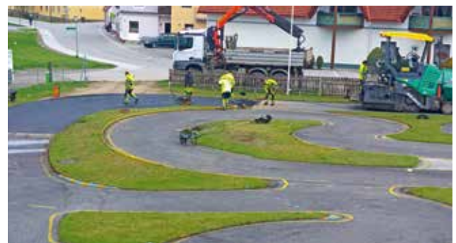
Sanierung des eingebrochenen Streckenabschnitts
