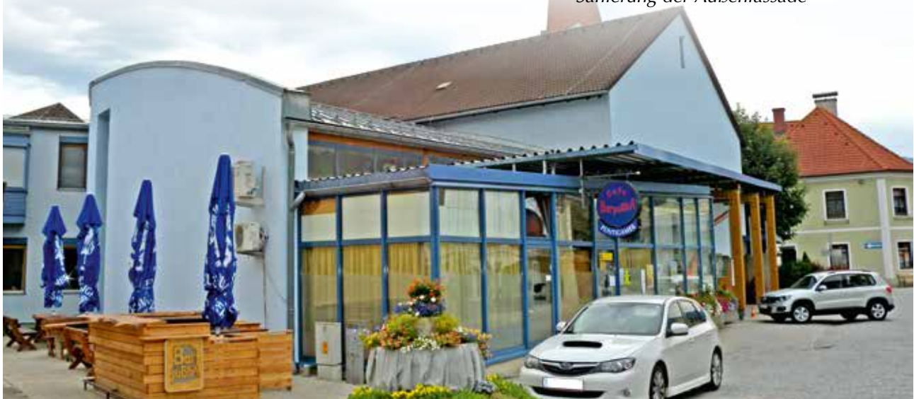
nach Abschluss der Sanierungsarbeiten erstrahlt das Gebäude im neuen Glanz
