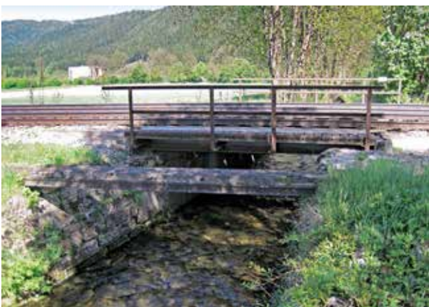
ÖBB-Brücke vor Beginn der Bauarbeiten
