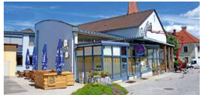
Sanierung der Außenfassade
