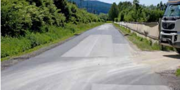
großflächige Sanierung der bestehenden Asphaltdecke
