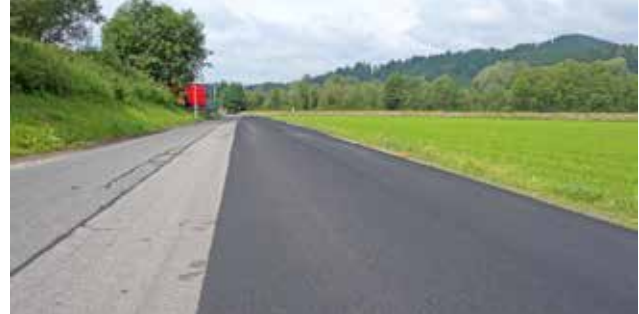
Aufbringung des Dünnschichtbelages
