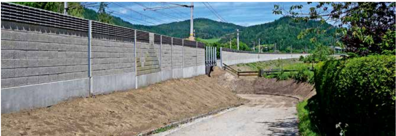
neue Lärmschutzwände entlang der ÖBB-Trasse in Freßnitz
