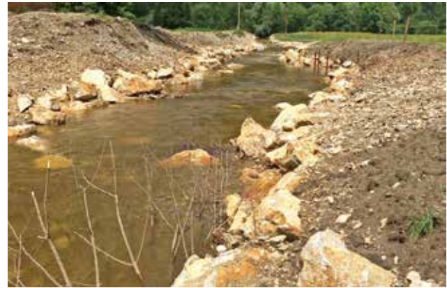
naturnaher Ausbau des Freßnitzbach-Unterlaufs
