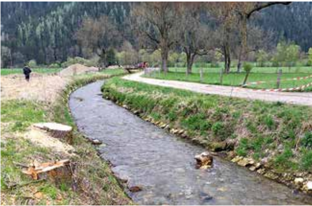
Freßnitzbach vor dem Ausbau
