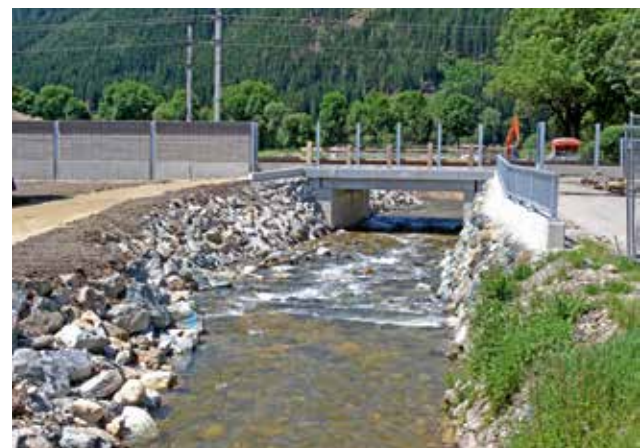
ökologisch aufwändige Bachverbauung und Neuerrichtung der ÖBB-Brücke
