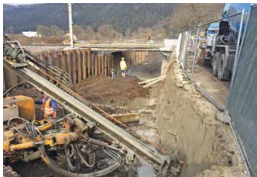
Stabilisierung der Uferbereiche
