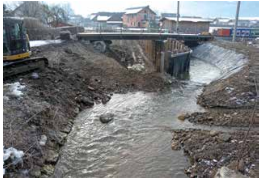
Errichtung der Behelfsbrücke und Umleitung des Freßnitzbachs
