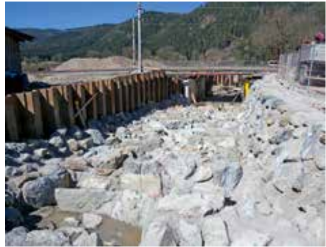
Verlegung von Flußbausteinen und Gestaltung des Bachlaufs
